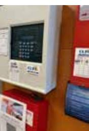
La seconde phase de l'installation du système de contrôle d'accès par badge a été mise en œuvre et les principales portes utilisées sont désormais contrôlées par ce dispositif qui permet de sécuriser les accès et de gagner en commodité par l'absence de clefs.
